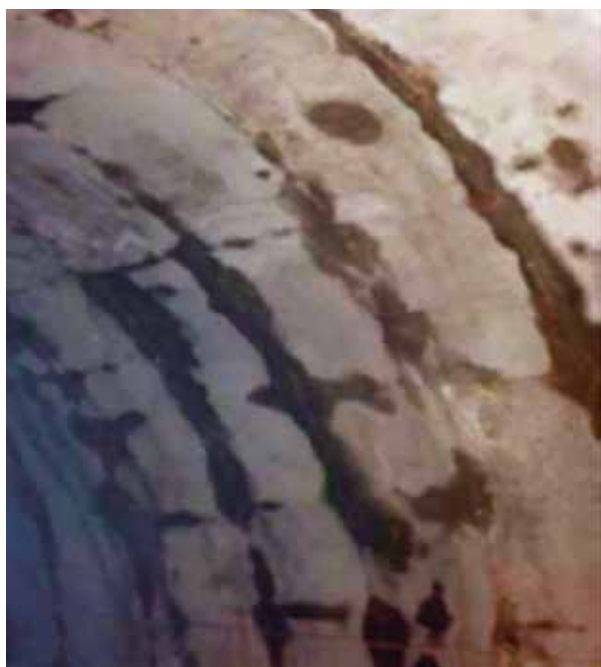
Просачивание воды через обделку тоннеля из монолитного бетона
