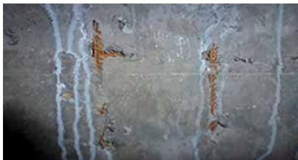
Недостаточная толщина защитного слоя
