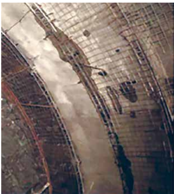
Просачивание воды через обделку тоннеля из монолитного бетона
